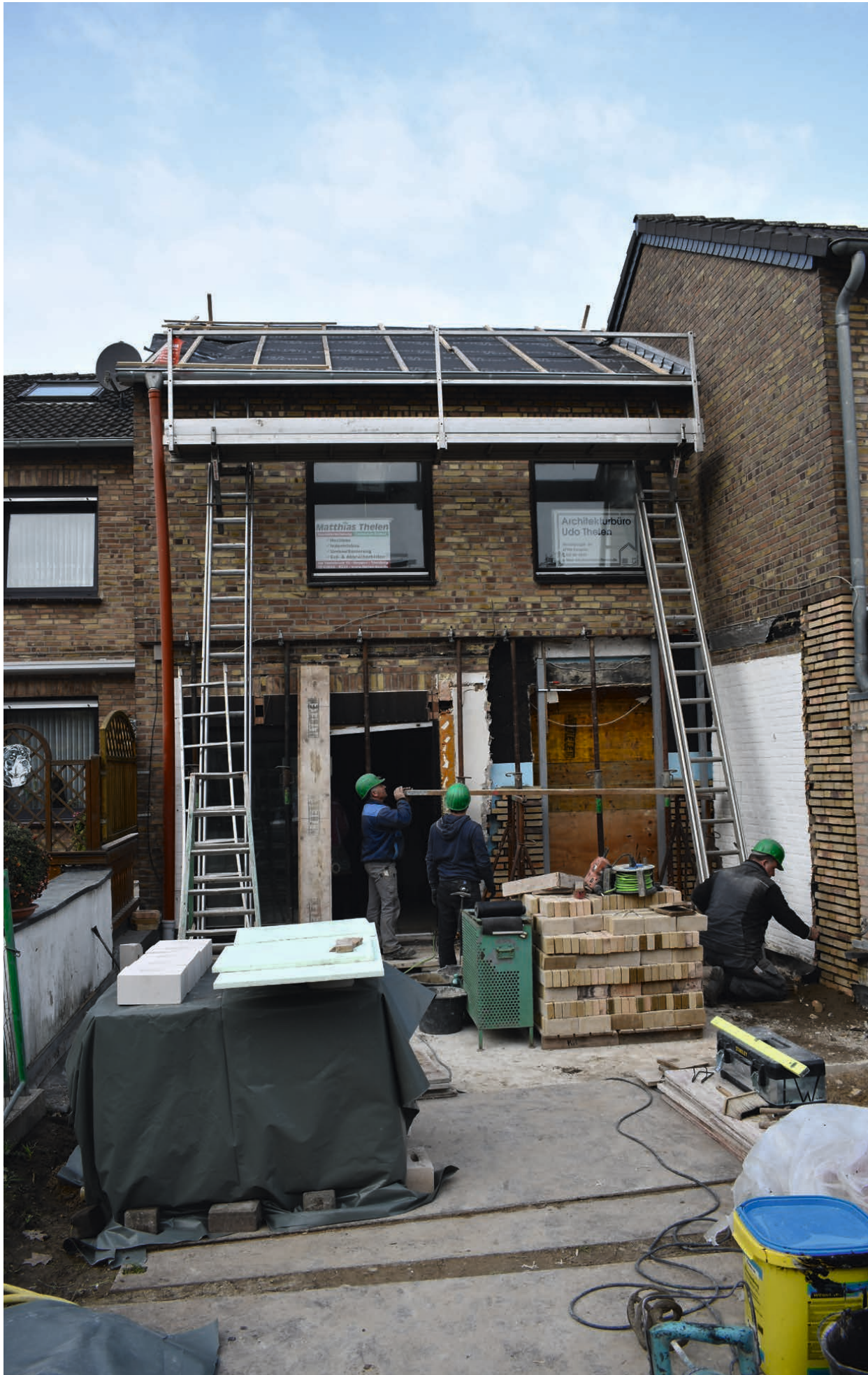
Bauarbeiten am Musterhaus
